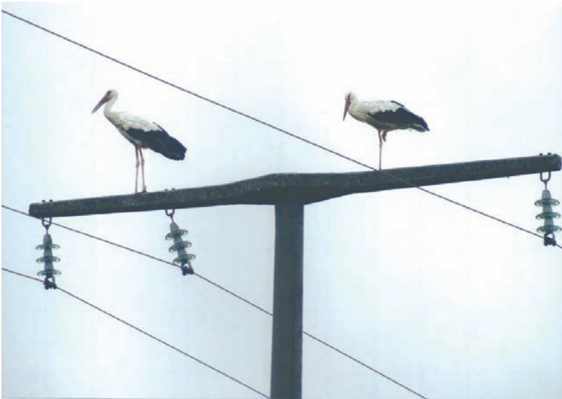
Fig. 10: Cigognes blanches sur un mât sûr pour les oiseaux, avec isolateurs suspendus. L'espacement entre l'arête supérieure de la console et les conducteurs doit être d'au moins 60 cm. (Photo: G. Fiedler)
