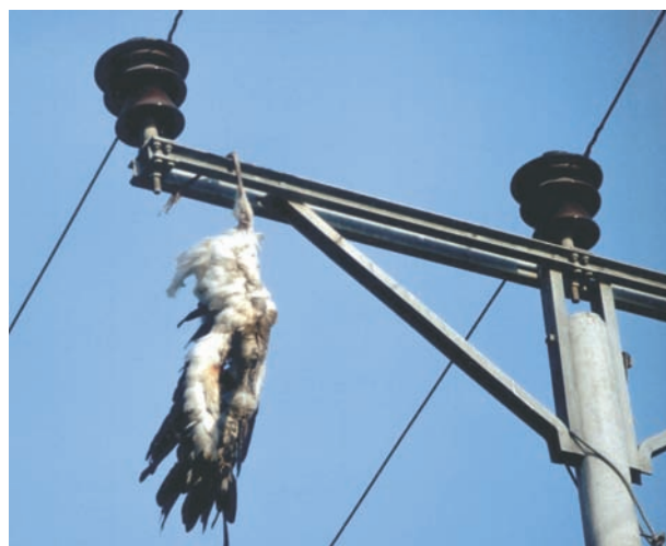
Fig. 2: Cigogne blanche électrocutée sur un mât équipé d'isolateurs dressés. Une deuxième cigogne blanche gisait à terre, morte. (Photo: G. Fiedler)
